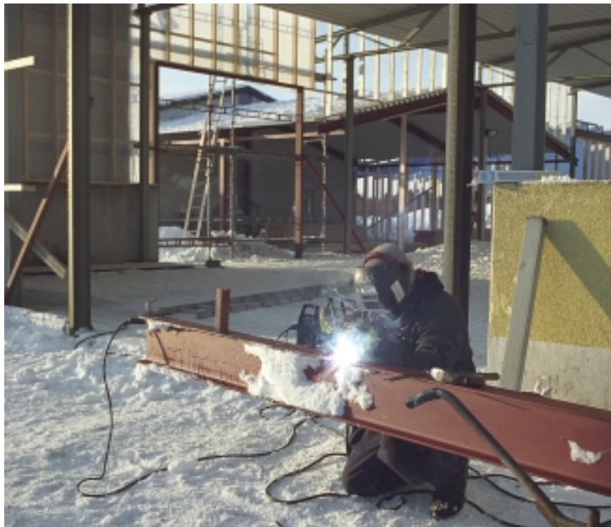
I mars månad börjar inflyttningen i Pentronics nya fabrik i Västervik. Så här långt var det byggt vid årsskiftet.
