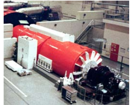
Styrsystemet registrerade för hög temperatur i den nya generatoren. Det hindrade kärnkraft- verket Oskarshamn 2 från att köra på full effekt. Orsaken var att temperaturgivarna stördes av generatorns magnetfält.
