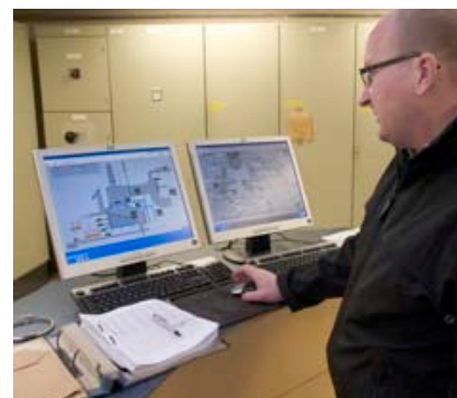
Hela anläggningen övervakas med ett stort antal temperaturgivare från Pentronic. Korrekt temperatur- och fukthaltsmätning är avgörande när produkten är ett eldfångt bränsle.
